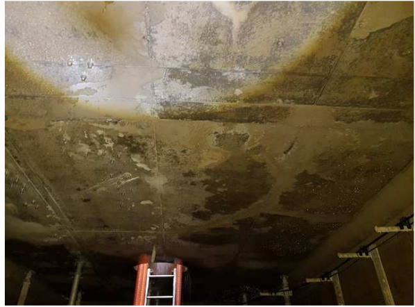
내용 상부슬레브 상태양호
